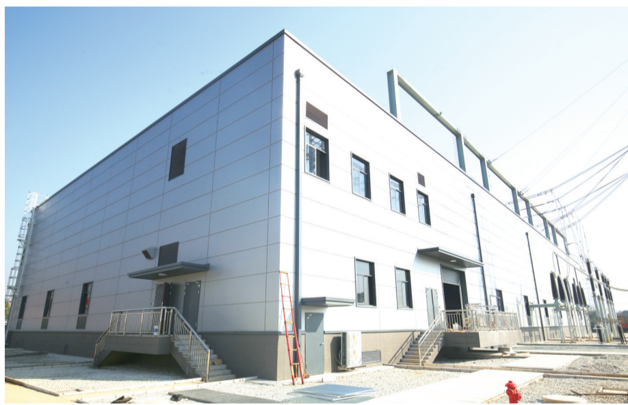
黄兴220千伏变电站。吴俊贤 摄
